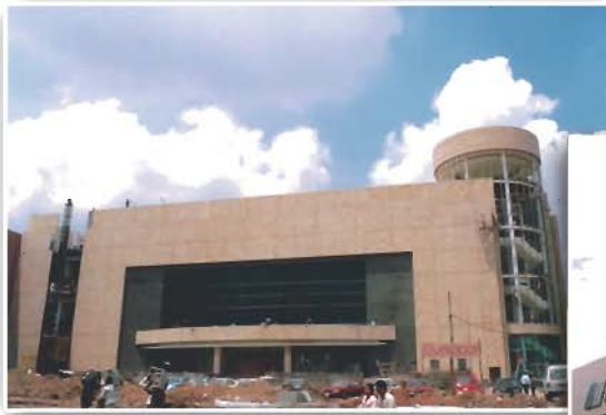
Obra en proceso
