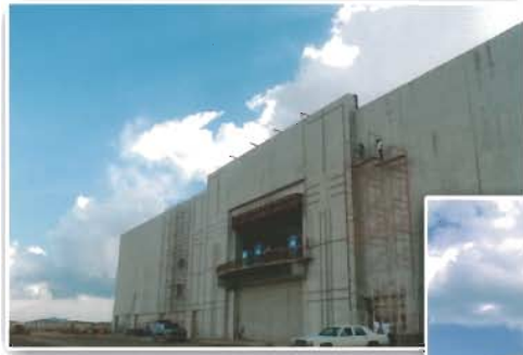
Obra en proceso
