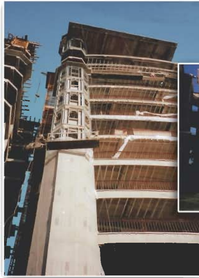
Obra en proceso
