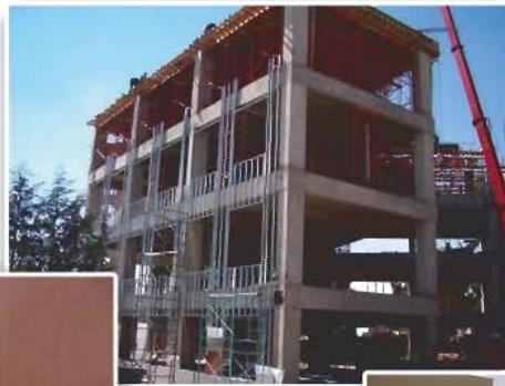
Obra en proceso
