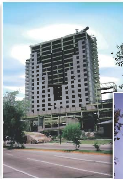
Obra en proceso
