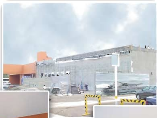
Obra en proceso
