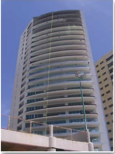
Obra en proceso
