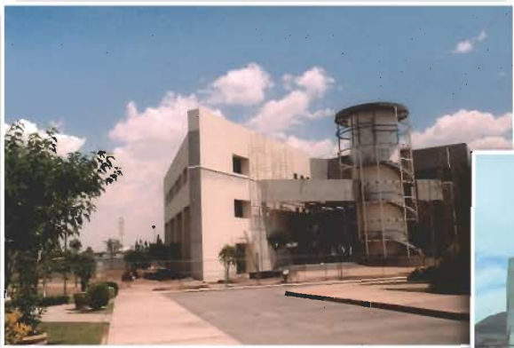
Obra en proceso
