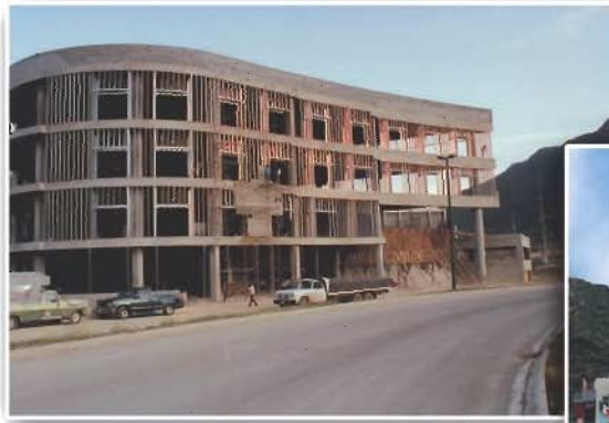
Obra en proceso
